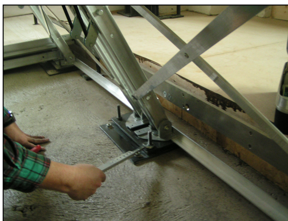
Chassiet bultas fast i golvunderlaget av betong.
