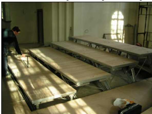
Däckskivan är utvald för att stämma överens med det gamla befintliga golvet i kyrkan.
