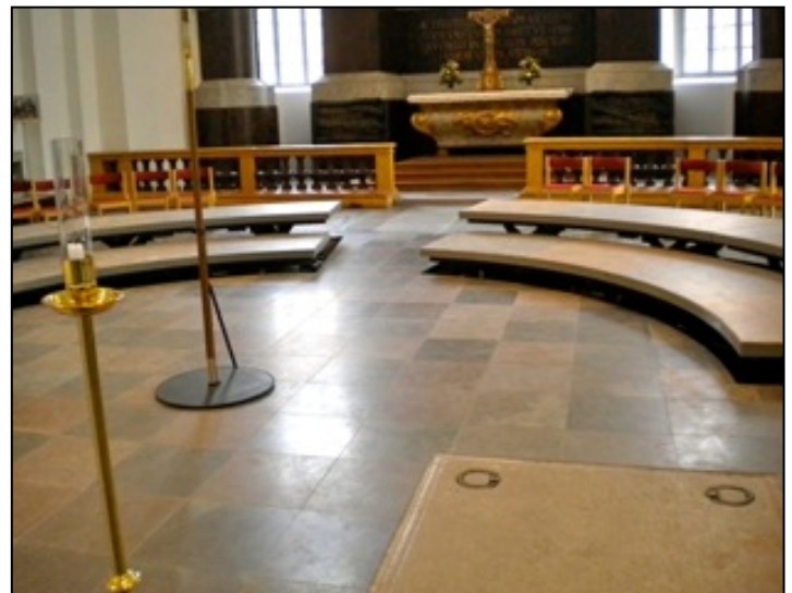
Podieraderna ställda i höjdläge 200 resp 400 mm. Manövreringen sker via en bärbar manöverpanel.
