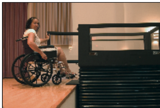
Grind och dockningsramp i det övre läget.
