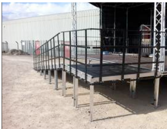
Utomhus rullstolsramp med väderbeständigt trädeck och aluminiumram. Benen av aluminium och av teleskoptyp.
